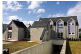
La RecyHouse avec sa toiture en tuiles de plastiques ménagers, ses murs en blocs de déchets de démolition concassés...
